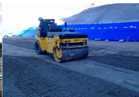
群馬県新条例準拠平成26年度新設最終処分場 ベントナイト層敷設工事
