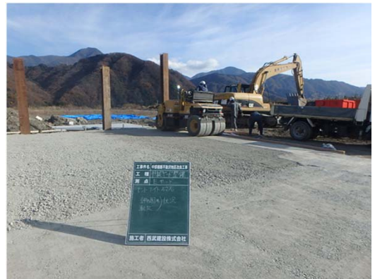
国土交通省関東地方整備局 NB 工法施工状況
