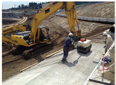
静岡県裾野市平成26年度管理型最終処分場 ベントナイト層敷設工事
